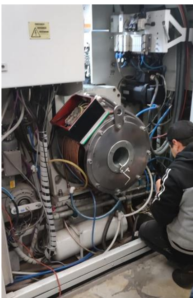
Figura 39. Intervención del personal de mantenimiento (Fuente: Elaboración propia)
